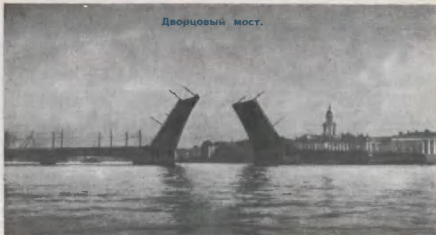
позволили инженеру А. И. Пшеницкому составить выдающийся по качеству проект. Он имел по тому времени огромный и к тому же единственный судоходный пролет шириной более 50 м, удивительный по красоте очертаний как в сомкнутом виде, так и с поднятыми ввысь крыльями. Остальные четыре пролета, по два с каждого берега, низко стелились у воды.
