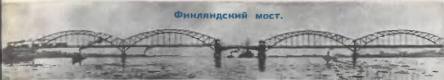
шириной 43 м. Береговые пролеты образованы арками и мощными железобетонными балками. Арки выполнены из металлических труб, заполненных бетоном, это значительно повышает прочность бетона на сжатие, а затяжки, работая как балки, также разгружают арку. Дорожное полотно жестко подвешено к аркам. Мост создает впечатление легкости, ажурности конструкции.
